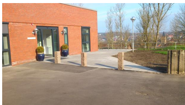
Facade med indgangsparti. Eksisterende granit pullerter bevaret
