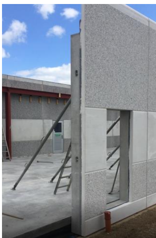
Montage af betonelementer
