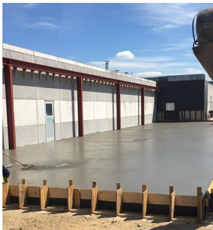
Udstøbning af terrændæk. Stålsøiler og bjælker monteret.
