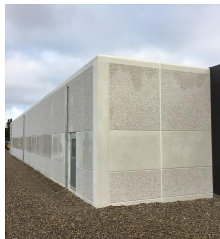
Ny facade af betonelementer (med glat spor)
