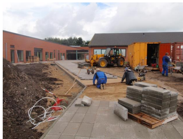
Belægningsarbejde pågår. Tilbygning ses til venstre, og eksisterende ses til højre. Mellem dem er ny forbindelsesgang
