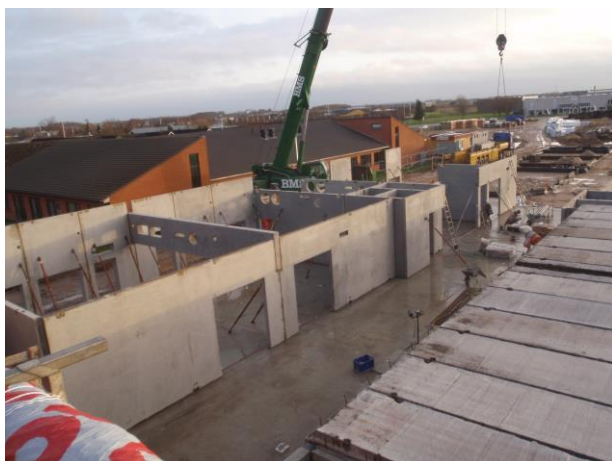
Montage af betonelementer/bagvægge pågår
