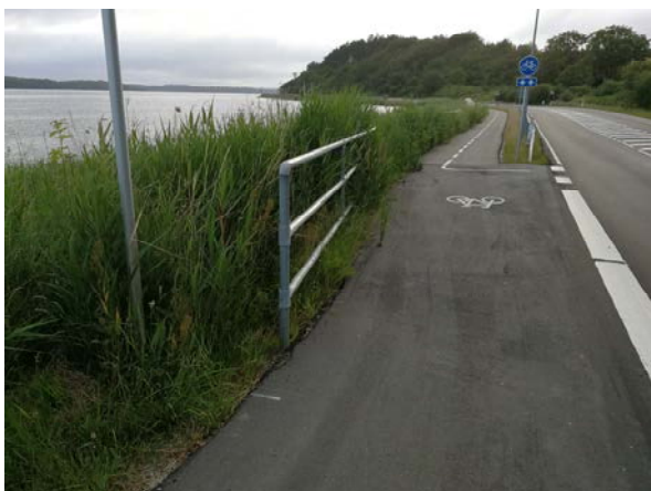
Overgang dobbeltrettet cykelsti/cykelbane
