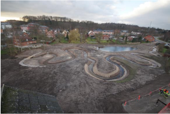
Terræn med omlagt Hodals bæk og etableret Hodals Møllesø umiddelbart efter færdiggørelse
