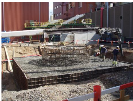
Armering af skorstensfundament
