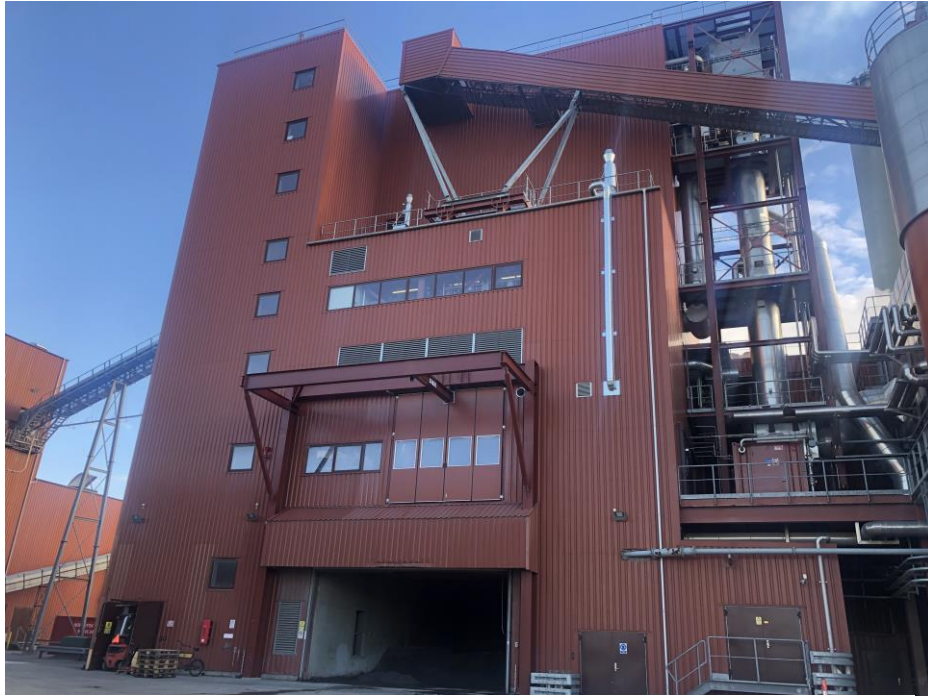
Front af ny smelteovnsbygning
