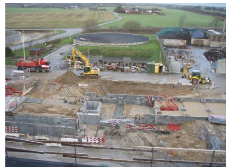
In-situ betonarbejde og jordarbejde pågår
