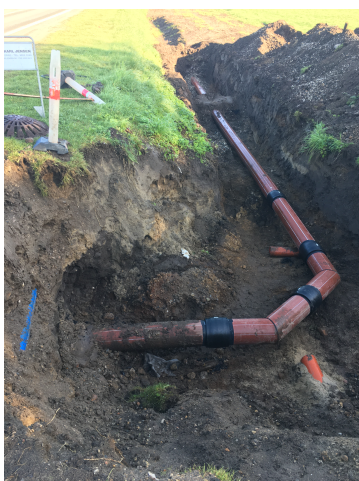
Overgang mellem trykledning i enkeltgrav og styret underboring, her ved krydsning af Aalborgvej til Erhvervsparken. Vandleddet anes i venstre side
