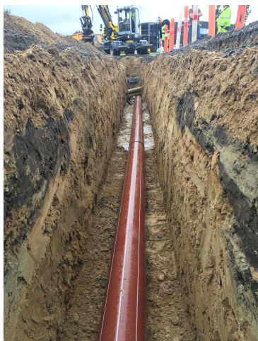
Trykledning i enkeltgrav. Krydsende el-ledning i baggrunden samt faskine
