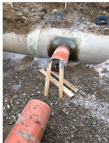
Tilslutning på eksisterende polyester ledning, for tilslutning af ny ledning, her ved Humlemarken
