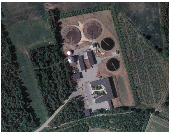
Renseanlæg før opstart
