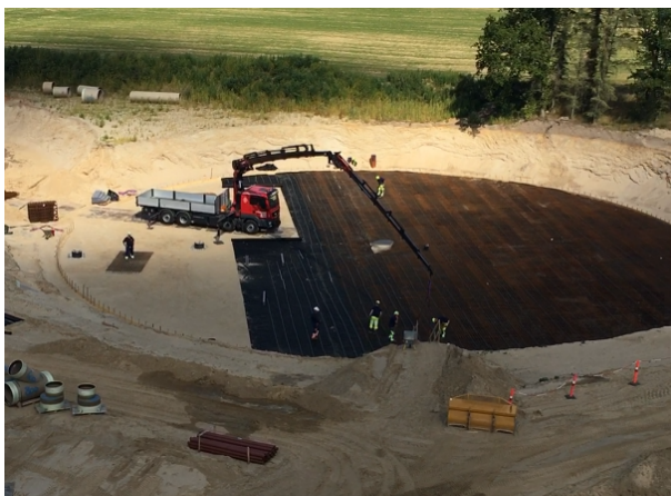
Armering af bundplade procestank 3
