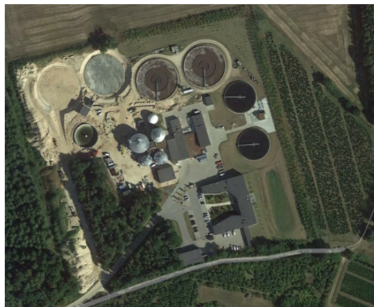
Renseanlæg under udvidelse
