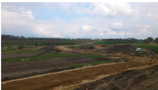
Kig ned ad Johannes V. Jensens Vej inden asfaltbelægning
