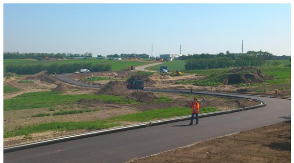
Kig ned ad Johannes V. Jensens Vej efter asfaltbelægning
